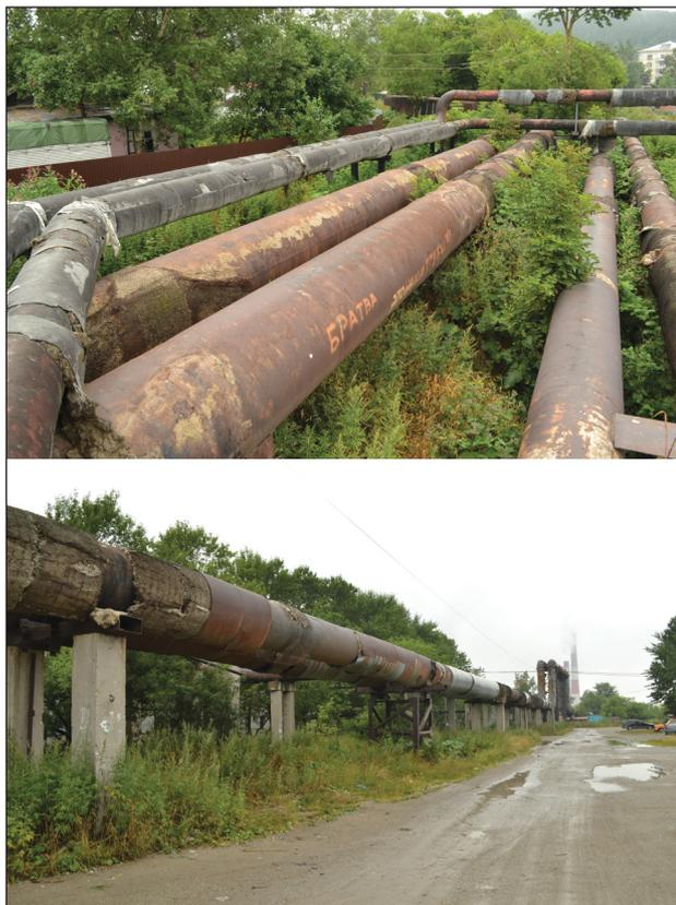
Рис. 1. Внешний вид участков теплотрассы надземной прокладки.
